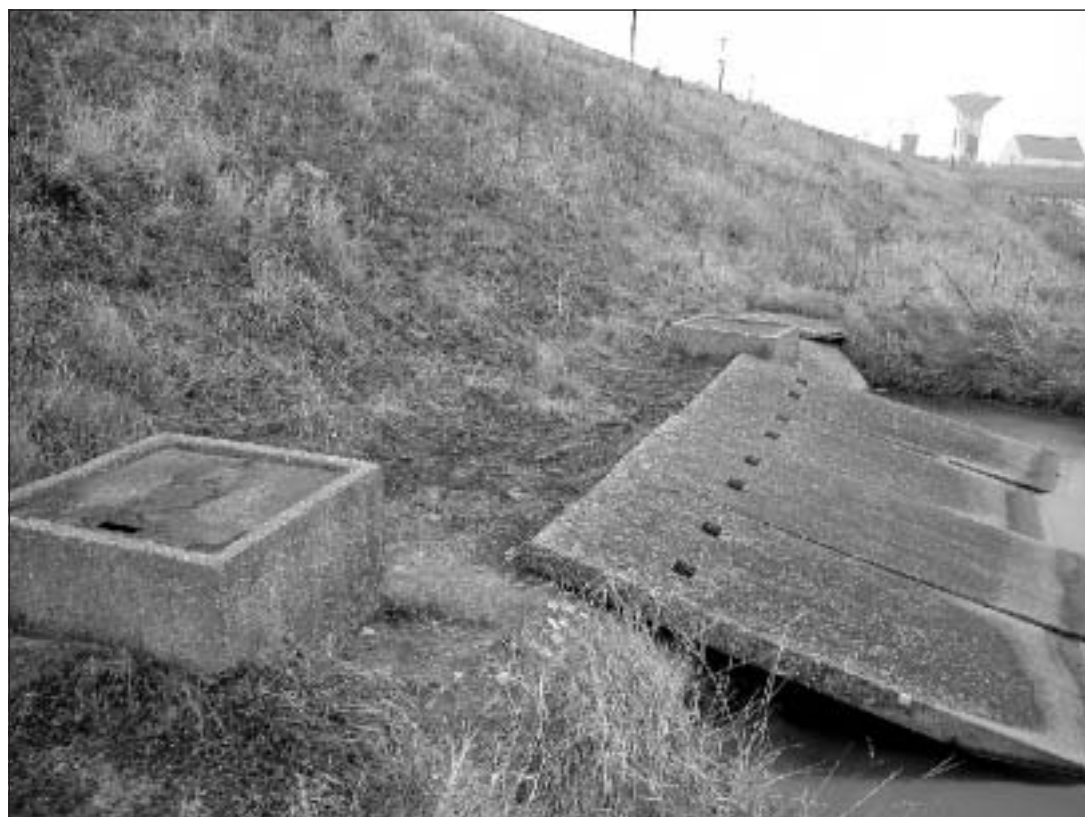
Des citernes et des filets d'une eau rougeâtre, en contrebas de l'autoroute (près du zoning industriel), témoignent encore de la présence des déchets dangereux sous l'A8. CE F.H. 610400
