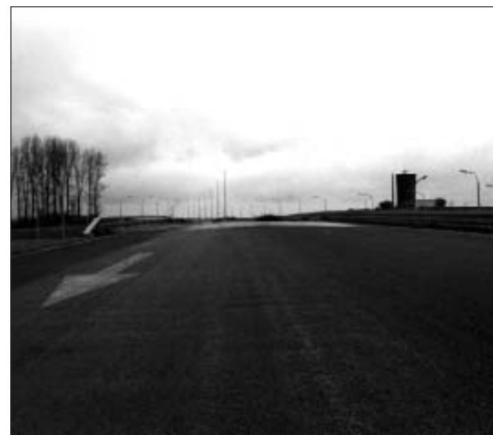
C'est ici que les déchets ont été déposés. Les travaux du plan de réhabilitation ont été effectués à la fin des années '90. CE 610770
