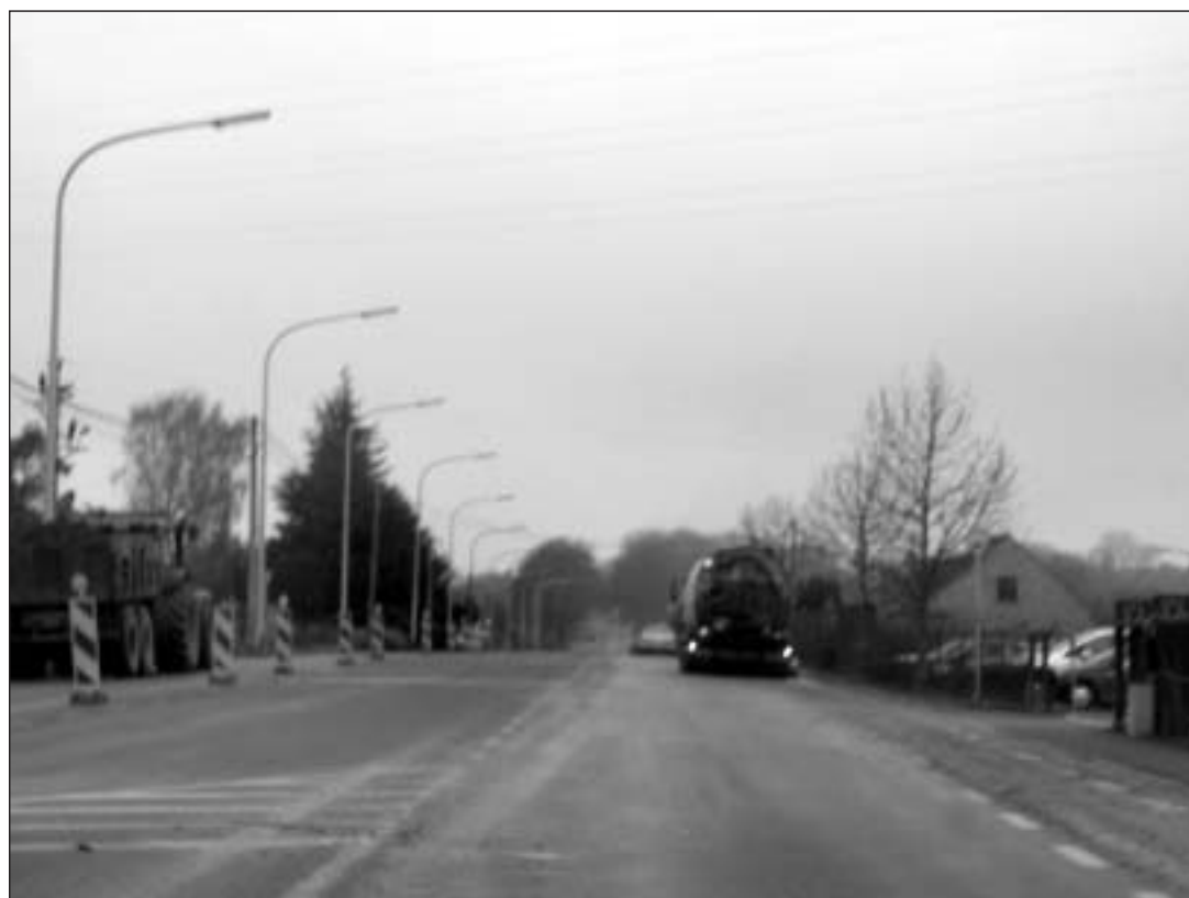
Des marquages au sol ont déjà amélioré la sécurité le long de la N7 à Meslin, à la hauteur d'une importante surface commerciale, mais d'autres aménagements sont étudiés.
